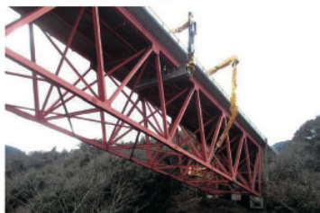
インフラ構造物点検
