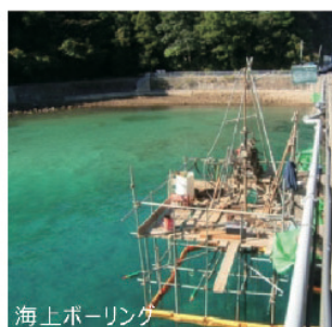
海上ボーリング
