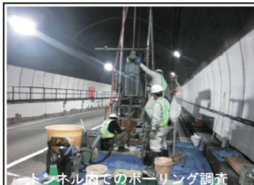
トンネル内でのボーリング調査
