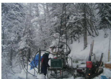
ボーリング調査
