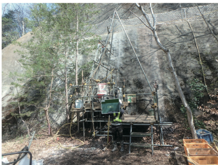
ボーリング調査
