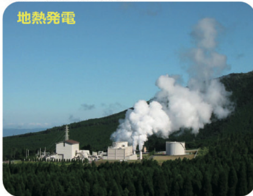
▲ 大霧地熱発電所(蒸気供給)
