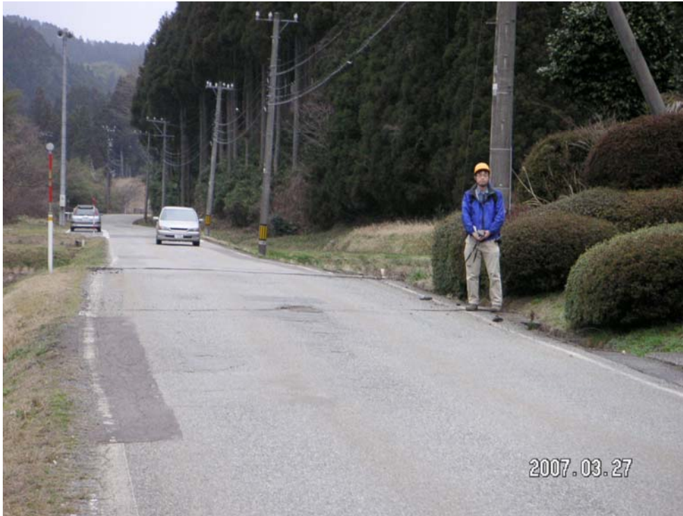
1141 断層確認地点の様子. 右手人物の足元の亀裂が断層
